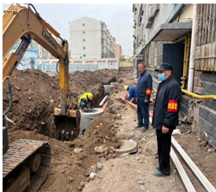
居民代表现场监督社区管网改造工程
