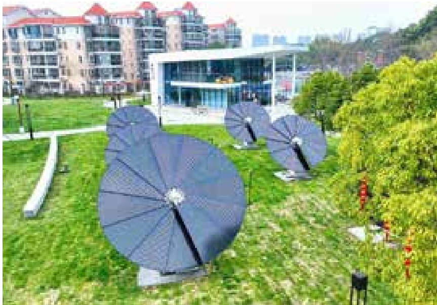
渊明公园光伏向日葵
